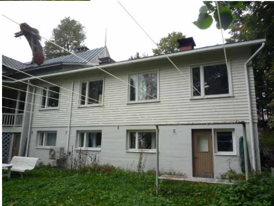
Laajennus lounaasta katsottuna.
