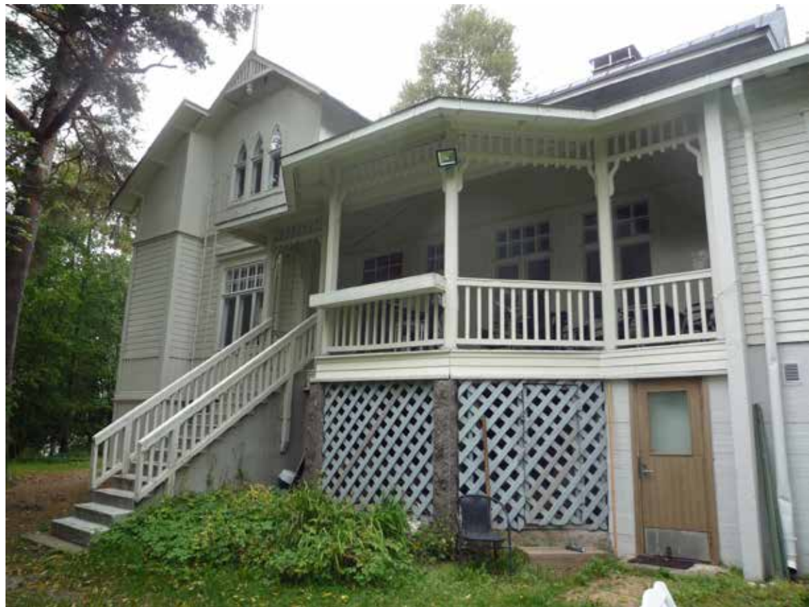
Veranta ja rantaan johtavat betoniporaat. Piirustuksista poiketen, verannan alaosa on jätetty auki ja peitetty harvalla ristilau-doituksella.
