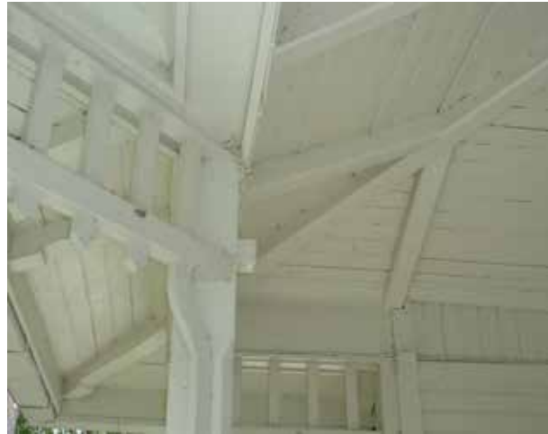
Verannan puurakenteisia kattorakenteita.
