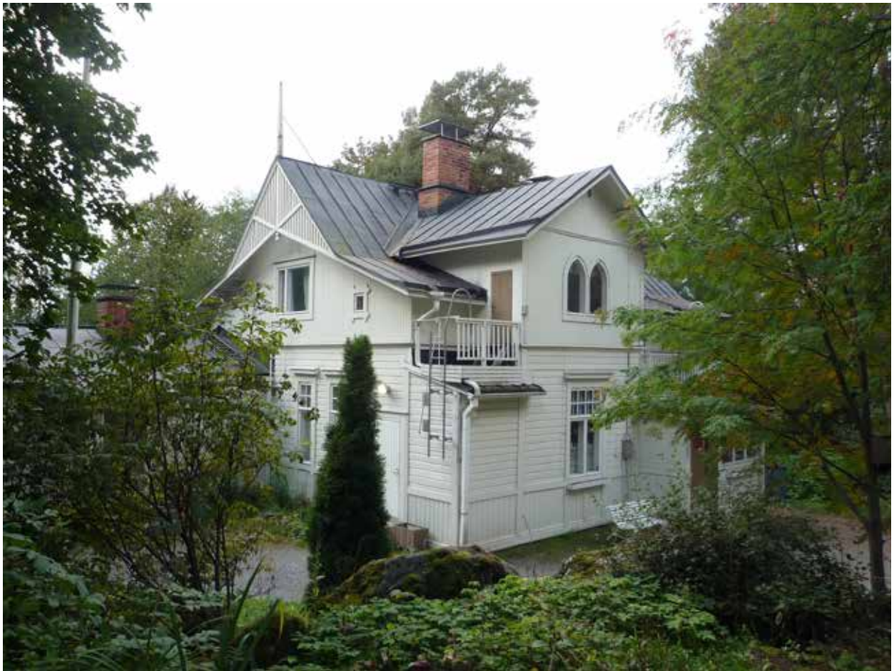
Rakennus idästä katsottuna.
