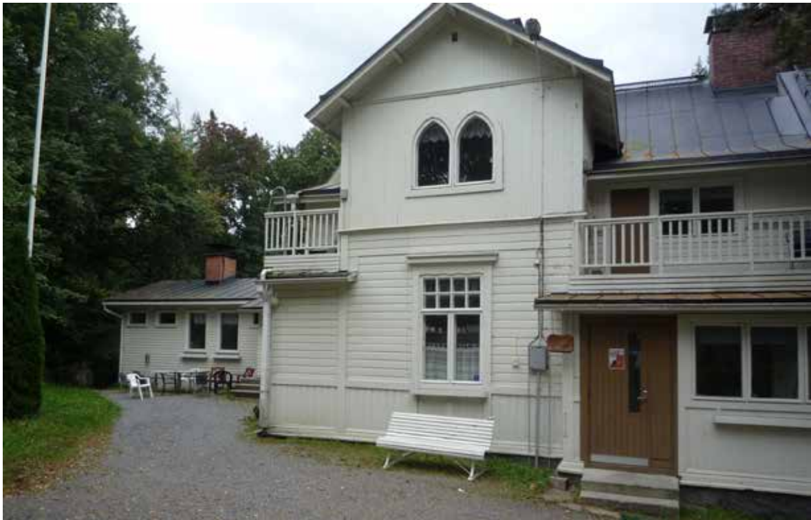
Näkymä pohjoisesta katsottuna. Etualalla päärakennus, taustalla laajennuksen päty.
